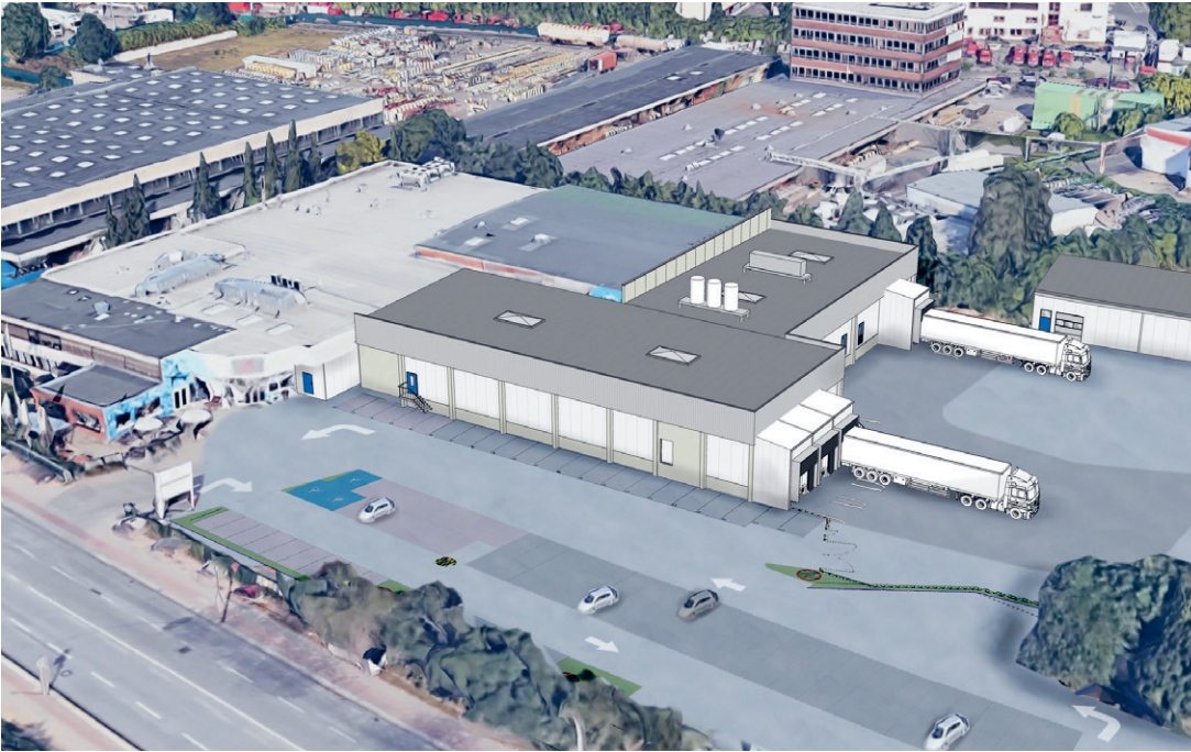
Umbau von Hagenah zur Fischplattform der EDEKA Minden-Hannover läuft auf Hochtouren.
